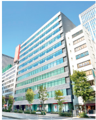
ヒューリック 虎ノ門ビル
