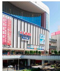
大井町再開発ビル1号棟 大井町再開発ビル2号棟
