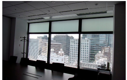
自然採光フィルム(ヒューリック虎ノ門ビル)
