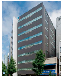
ヒューリック 神田ビル
