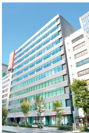
ヒューリック 虎ノ門ビル
