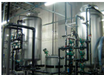
地下鉄湧出水濾過装置設置状況 (御茶ノ水ソラシティ)
