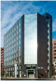
ヒューリック 両国ビル
