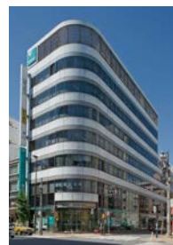
ヒューリック 東上野一丁目ビル
