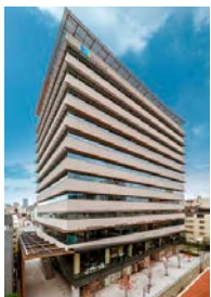
ヒューリック 浅草橋ビル
