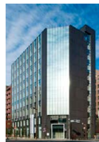
ヒューリック 両国ビル
