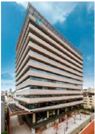
ヒューリック 浅草橋ビル
