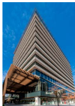
ヒューリック 浅草橋ビル
