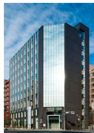
ヒューリック 両国ビル
