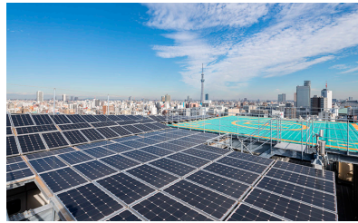
ヒューリック浅草橋ビル
