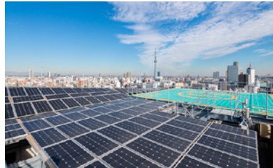
ヒューリック浅草橋ビル
