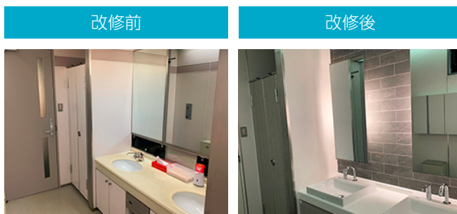
ヒューリック渋谷一丁目ビル：各階トイレリニューアル工事
