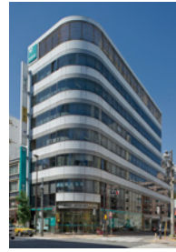
ヒューリック 東上野一丁目ビル
