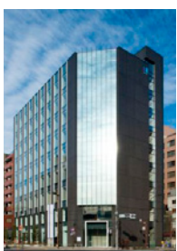
ヒューリック 両国ビル
