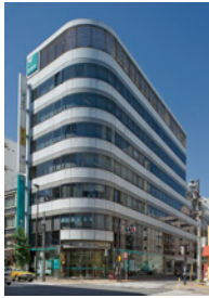
ヒューリック 東上野一丁目ビル
