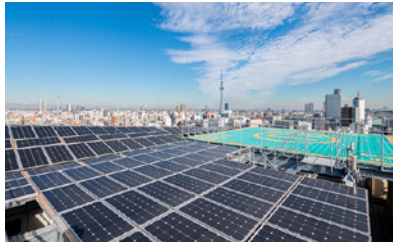
ヒューリック浅草橋ビル
