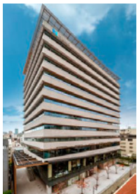
ヒューリック 浅草橋ビル
