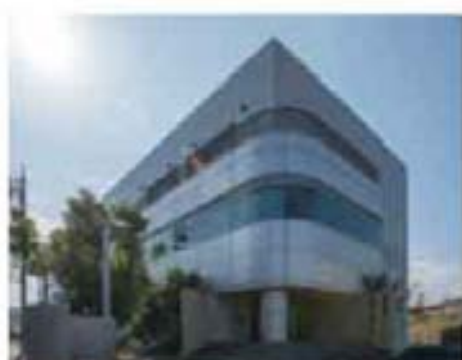
熱田ネットワークセンター Atsuta Network Center 所在地: 愛知県名古屋市中熱田区榎野町20番1号 稼働率: 100.0%
