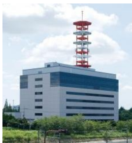
NW-06 Network Center
