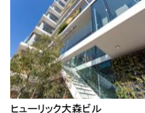
ヒューリック大森ビル
