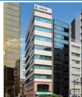
OF-24 オフィス 駅徒歩4分 ヒューリック飯田橋ビル
