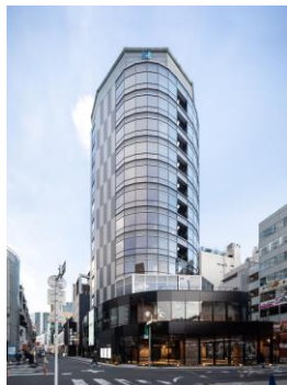
HULIC & New UDAGAWA （2021年3月竣工）
