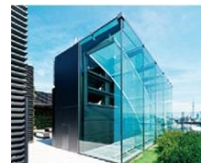
屋上ソーラーチムニー （ヒューリック本社ビル）
