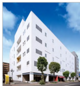
NW-07 ネットワークセンター
