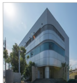
NW-04 ネットワークセンター
