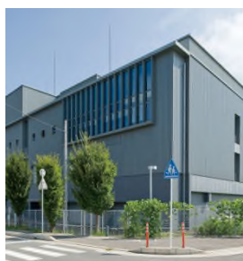
NW-08 ネットワークセンター
