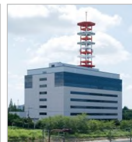
NW-06 ネットワークセンター
