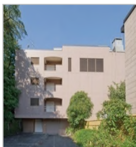
NW-02 ネットワークセンター
