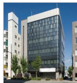
NW-05 ネットワークセンター
