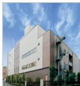
NW-01 ネットワークセンター
