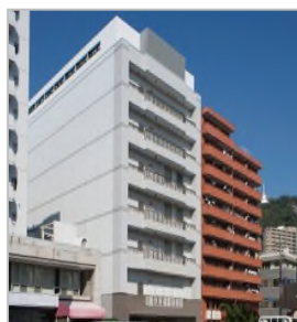
NW-03 ネットワークセンター
