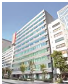
ヒューリック 虎ノ門ビル
