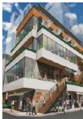
HULIC &New 吉祥寺 (2019年8月竣工)
