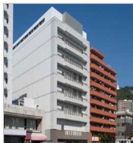
NW-03 ネットワークセンター
