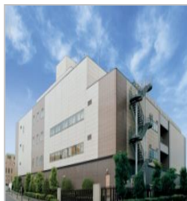
NW-01 ネットワークセンター
