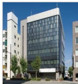
NW-05 ネットワークセンター
