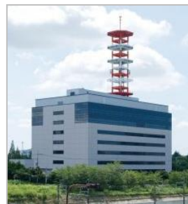
NW-06 ネットワークセンター
