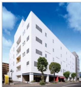
NW-07 ネットワークセンター
