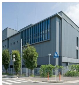
NW-08 ネットワークセンター
