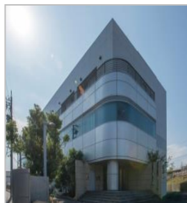
NW-04 ネットワークセンター
