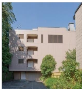
NW-02 ネットワークセンター
