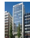
ヒューリック神田橋ビル 空調機器更新
