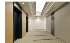
ヒューリック高田馬場ビル 共用部のLED化
