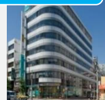
ヒューリック 東上野一丁目ビル
