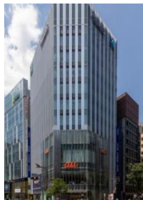
ヒューリック 新宿ビル
