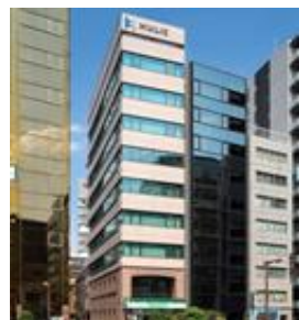
OF-24 オフィス 駅徒歩4分 ヒューリック飯田橋ビル
