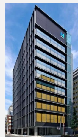
ヒューリック本社ビル
