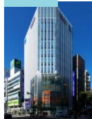
ヒューリック 新宿ビル
