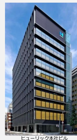
ヒューリック本社ビル
