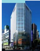
ヒューリック 新宿ビル
