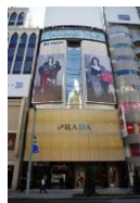
2 ヒューリック 銀座ワールド タウンビル
