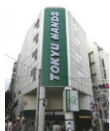
1 ヒューリック 渋谷宇田川ビル
