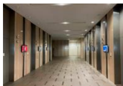
エレベーターホールに テレビモニターを設置
