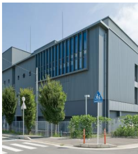
NW-08 ネットワークセンター
