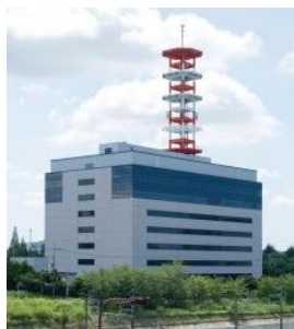
NW-06 ネットワークセンター
