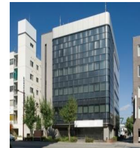
NW-05 ネットワークセンター
