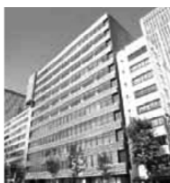
ヒューリック虎ノ門ビル 2017 〇〇〇〇
