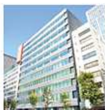
ヒューリック虎ノ門ビル 2017 ○○○○
