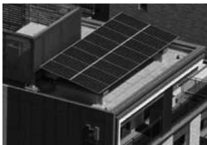
＜屋上太陽光パネルの設置＞
