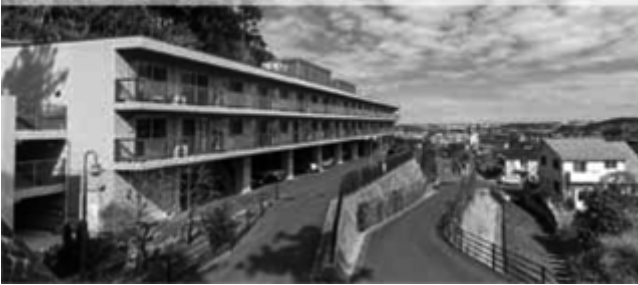
閑静な住宅街に囲まれた高台の有料老人ホーム
