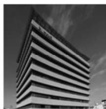
⑥ヒューリック浅草橋ビル
