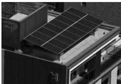
＜屋上太陽光パネルの設置＞
