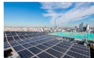
ヒューリック浅草橋ビル
