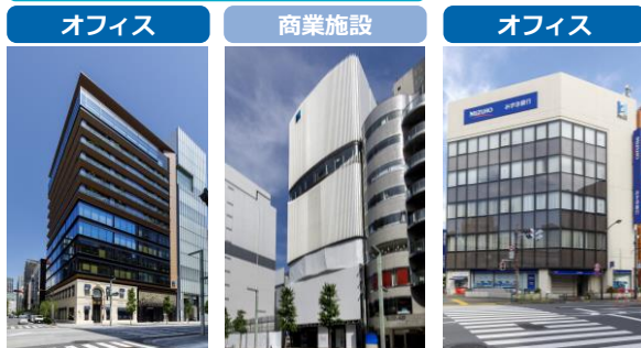
ヒューリック 銀座ビル 区分所有建物 (49.0%)
