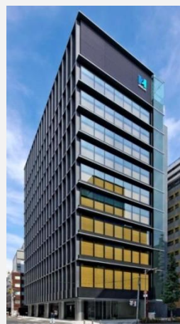
ヒューリック本社ビル
