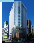
ヒューリック新宿ビル
