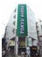
2 ヒューリック 渋谷宇田川町 ビル
