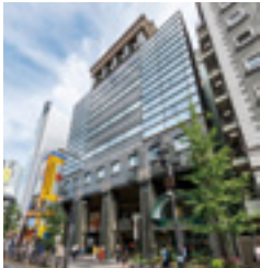
OF-04 オフィス 駅直結 ラピロス六本木
