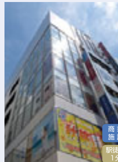
ヒューリック新宿三丁目ビル
