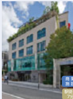
ヒューリック神宮前ビル
