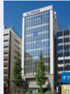
ヒューリック神田橋ビル
