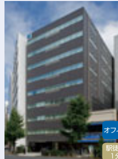
ヒューリック神田ビル
