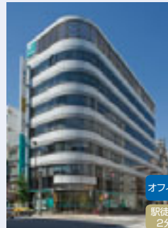
ヒューリック東上野一丁目ビル
