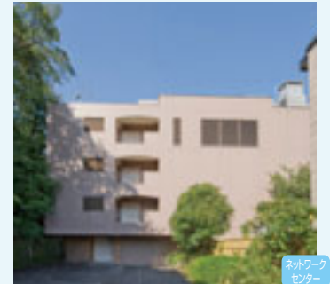
田端ネットワークセンター
