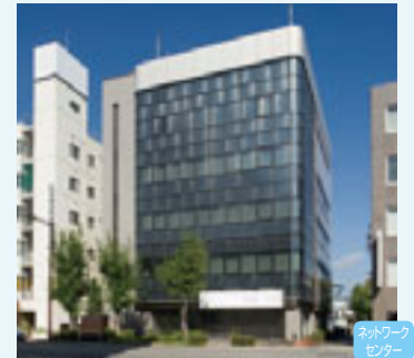
長野ネットワークセンター
