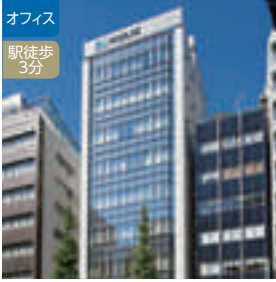
OF-07 ヒューリック神田橋ビル
