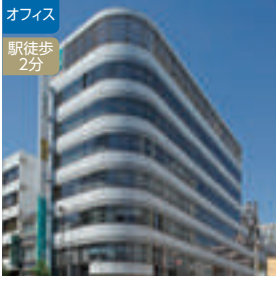
OF-10 ヒューリック東上野一丁目ビル
