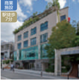
RE-04 ヒューリック神宮前ビル
