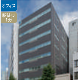
OF-06 ヒューリック神田ビル
