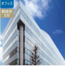
OF-11 笹塚サウスビル
