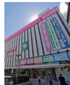
大井町再開発 ビル2号棟
