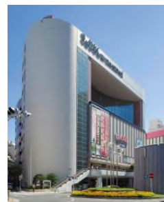
大井町再開発 ビル1号棟
