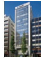
ヒューリック神田橋ビル 空調機器更新
