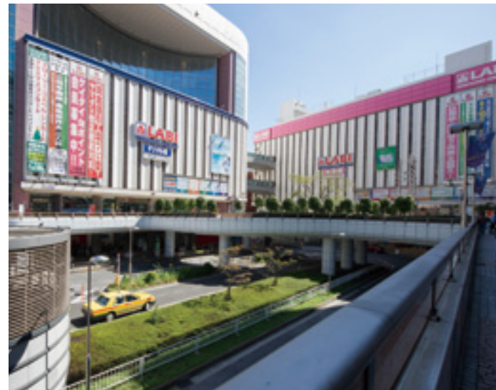
大井町再開発ビル1号棟
