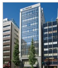
ヒューリック神田橋ビル
