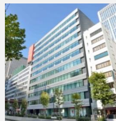
ヒューリック虎ノ門ビル
