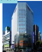
ヒューリック新宿ビル
