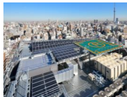
屋上太陽光発電パネル
