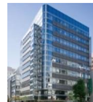
ヒューリック蛸殻町ビル (省エネ診断実施物件)
