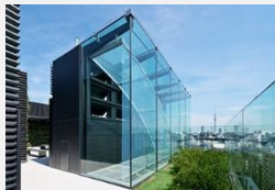
ヒューリック本社ビル 屋上自然換気システム
