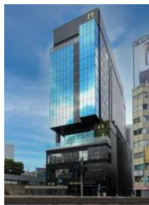
ヒューリックスクエア東京 (ザ・ゲートホテル東京 by HULIC)
