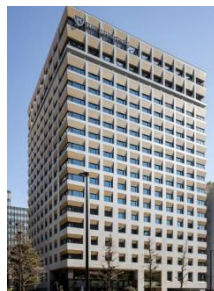
ヒューリック銀座六丁目昭和通ビル (ザ・ロイヤルパークホテル 銀座6丁目)
